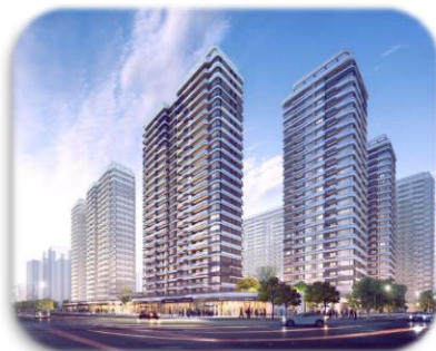
住宅项目 杭州世纪
