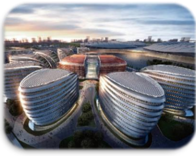
城市综合体项目 上海虹桥世界中心
